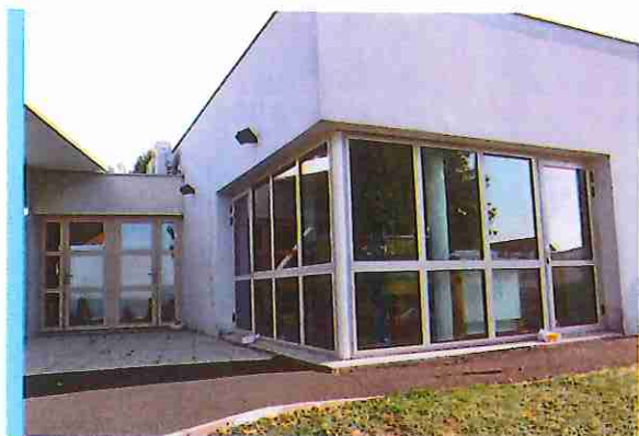
Changement des baies vitrées à la maison de l'enfance.
