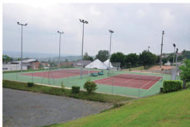
Réfection et changement de l'éclairage sur les cours de tennis
