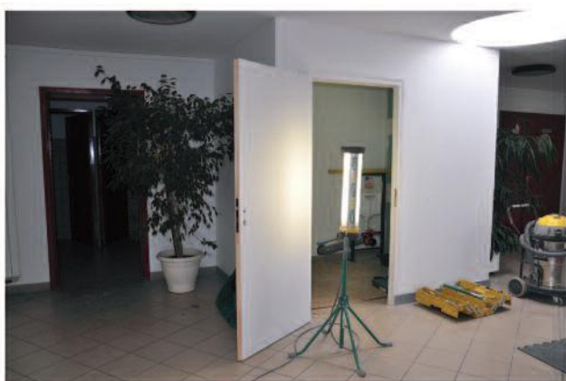
Installation d'un WC handicapé et réfection des urinaires à la salle des fêtes
