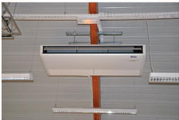
Installation d'une climatisation à la salle des fêtes
