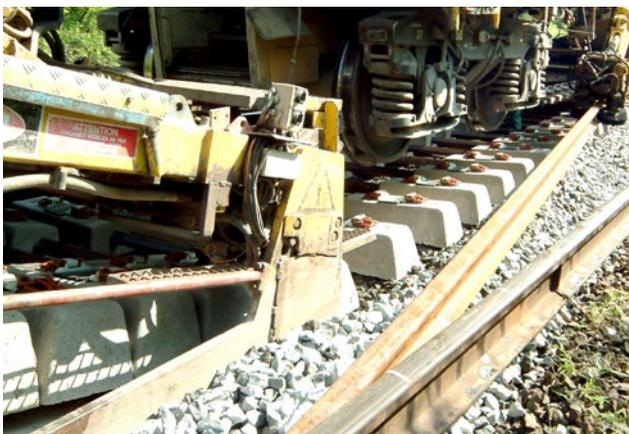
Les anciens rails sont détirefonnés puis écartés de la voie par le train de substitution. Celui-ci enlève ensuite les vieilles traverses et les remplace immédiatement par des traverses monobloc en béton précontraint équipées d'attaches de fixation rail/traverse "FastClip". Les longs rails neufs de 400 mètres, déchargés préalablement sur le côté de la voie, sont progressivement mis en place, fixés sur les traverses puis soudés entre eux par aluminothermie.
