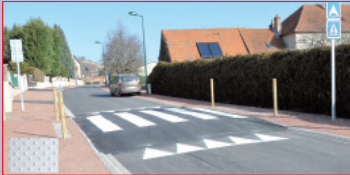
Ralentisseur de la rue des Cornillons. Des bandes d'éveil de vigilance pour les non-voyants sont collées de chaque côté du ralentisseur.
