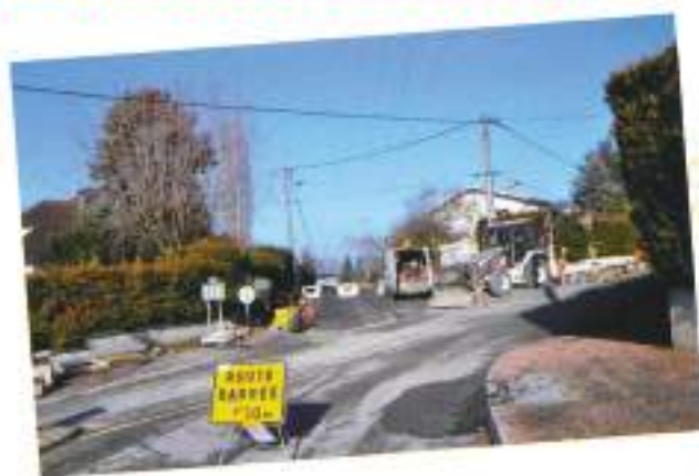
Travaux d'assainissement rue de Vichy, reprise de l'ensemble des branchements, la circulation dans la rue va être perturbée pendant plusieurs mois.
