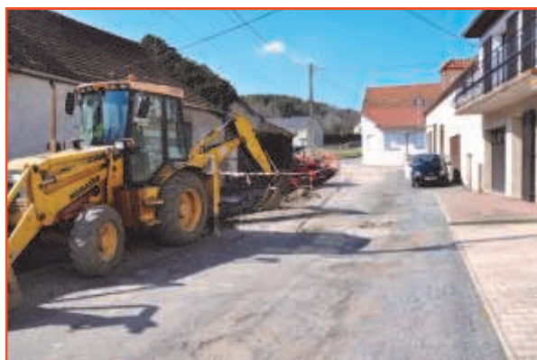
Enfouissement des réseaux rue de l'Enfer
