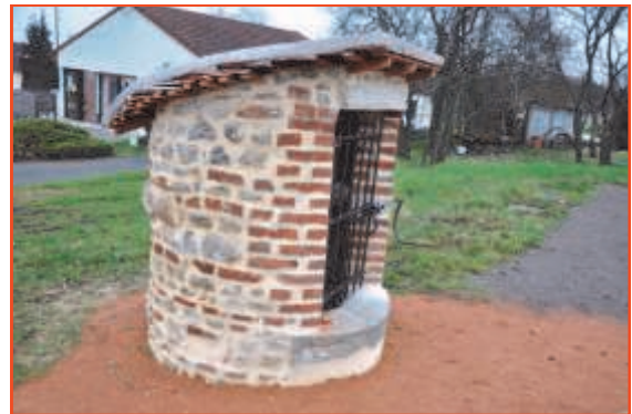
Réfection d'un puit aux Guinards
