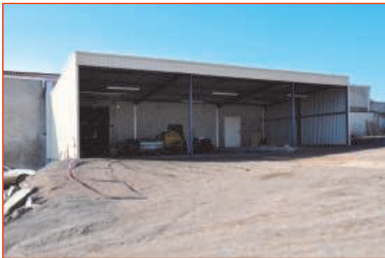
Agrandissement des hangars
